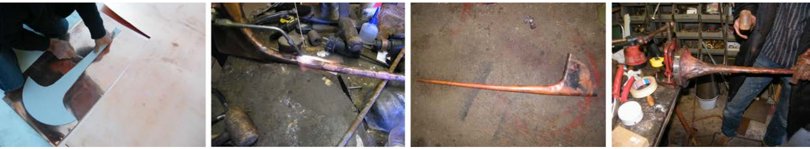
Figura 4 Da esquerda para direita: Corte da chapa. Soldagem.
