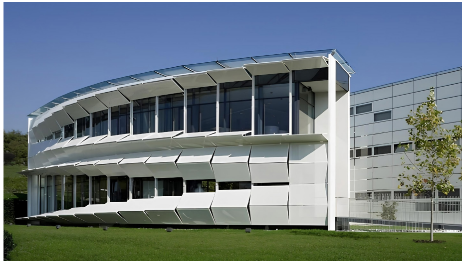
Figura 1: Proteções solares dobráveis cujo movimento pode ser determinado por lógicas computacionais.
